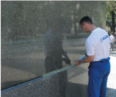
Afdichten van een gevelvoeg met Mapesil LM
